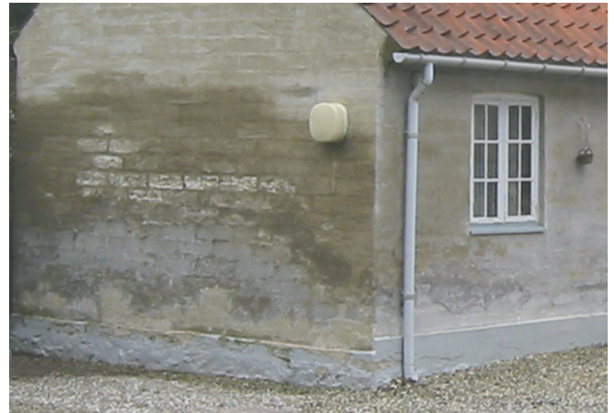
over terræn. Herefter bør huset afrenses for al maling udvendig, gennemgås for at fjerne cementfuger – og enten blot kalkes hvidt eller stå i kridtstenens egen overflade. Foto: Søren Vadstrup.
