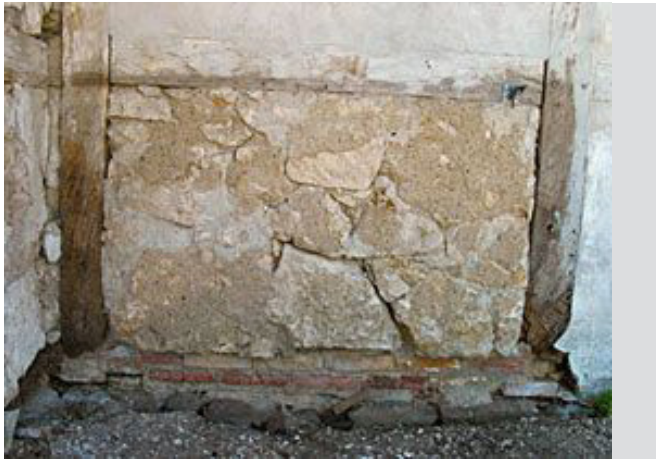
Øverst: Kassemur med vandret skiftegang. Foto: Anne Lindgaard. Nederst: Rå kridtstensblokke passet sammen. Foto: Østsjællands Museum.
