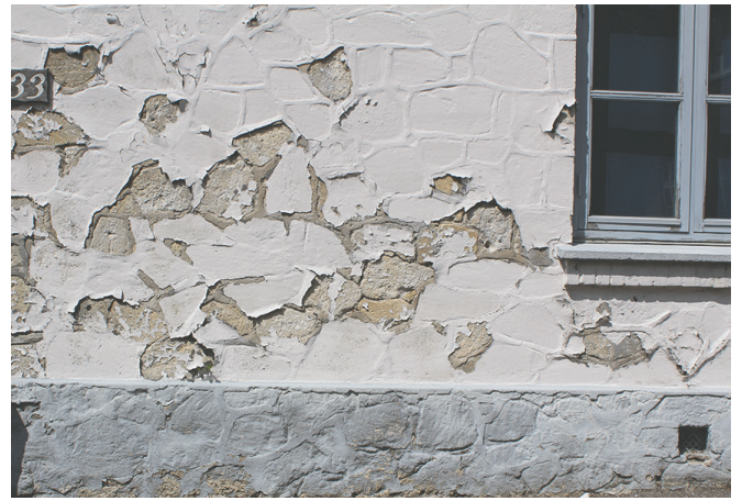
I dette tilfælde har plastikmalingen udviklet sig til at være mindre skadelig for kridtstensmurværket, fordi den er begyndt at skalle af, men før dette har den bevirket et mere fugtigt indeklima i huset. Foto: Anne Lindegaard.
