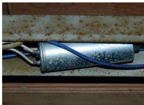
Ældre kondensatorer indeholder ofte PCB
