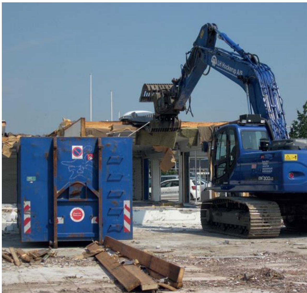
Nedrivning hvor affaldet sorteres umiddelbart.
