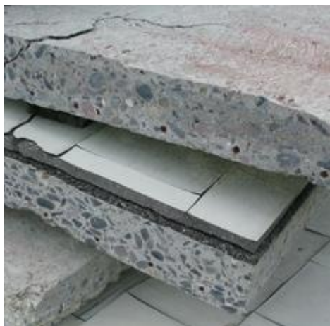
Betondæk fra industribygning. Gulvet er belagt med asfalt og vinylfliser. Indeholder tjærestoffer, asbest og blødgørere.
