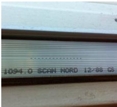
Prægningen i rudens afstandsliste viser, at ruden er fremstillet i december 1988 (12-88). Ruden indeholder derfor ikke PCB.
