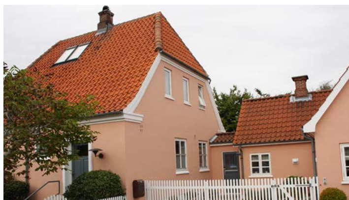
Velbevaret bebyggelse fra villaområdet bag Stevnsvej
