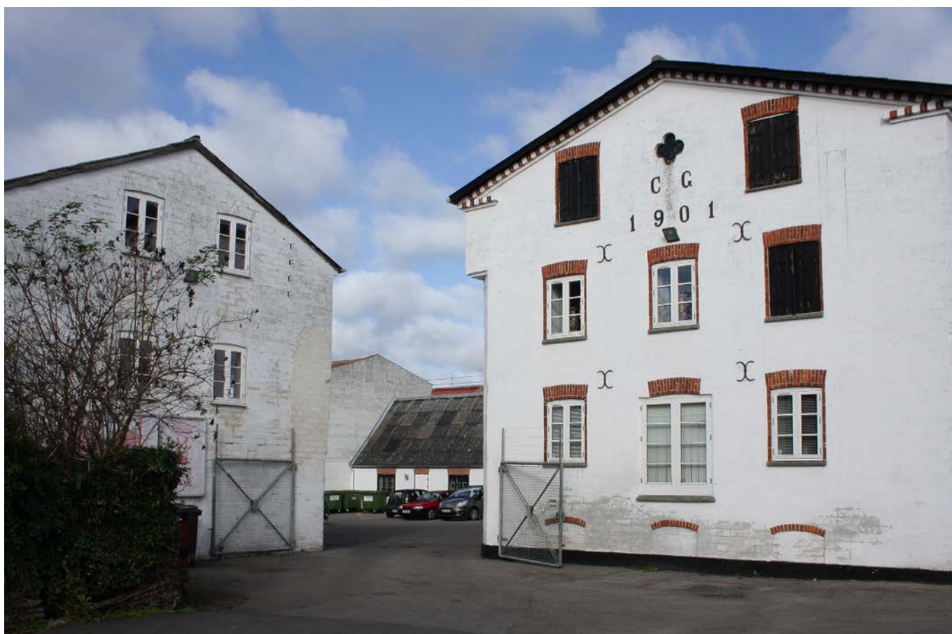
De smukke lager- og erhvervsbygninger fra Store Heddinge er opført i kridtsten og pyntet med røde teglstensstik og en fin gesims
