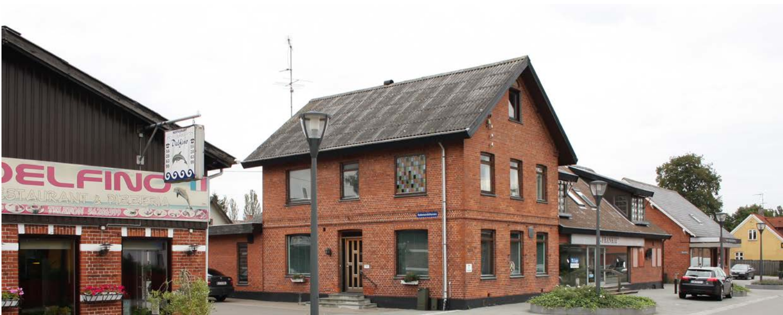
I området omkring Hovedgaden og stationen er der huse i op til 2½ etage
