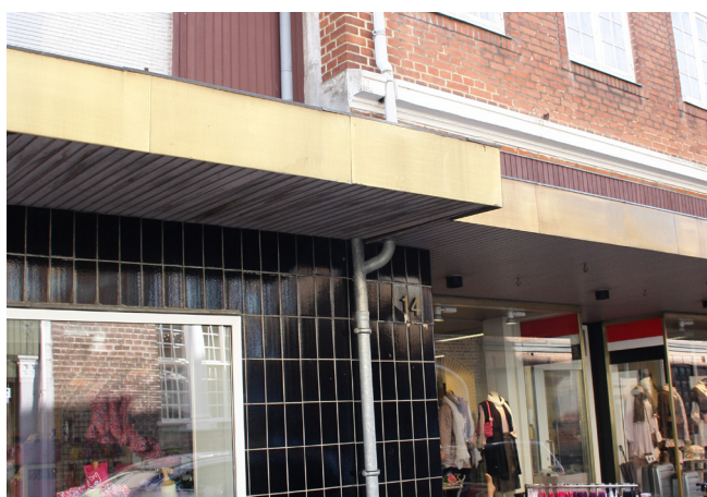
Ombygning og ny facadebeklædning skjuler den oprindelige facade
