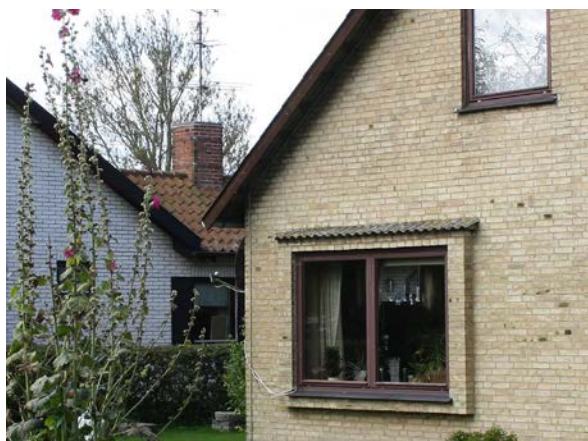
Bygningsdetalje i form af muret indramning af vindue
