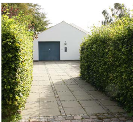
Chaussésten markerer overgangen mellem privat og offentligt område
