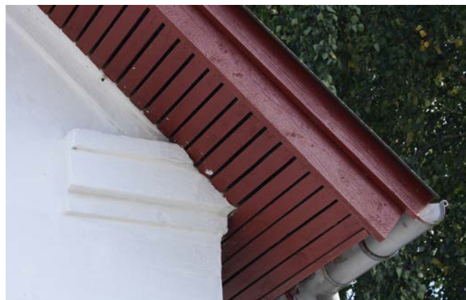
Boligen har gennem renovering fået tilført udhæng på husets tag, hvilket går ud over gesimsen
