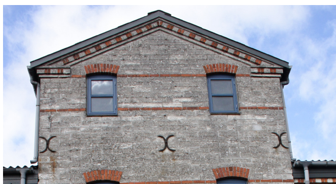
Det tidligere bryggeri i Store Heddinge er bygget i kridtsten med meget fine detaljer
