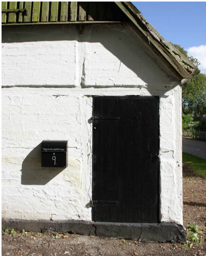
Det overkalkede bindingsværk er en sydsjællandsk byggeskik
