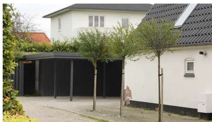
De smalle grusveje, beplantning og bebyggelse danner harmoni
