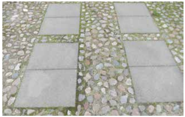
Enkel belægning med beton og traditionelle pigsten
