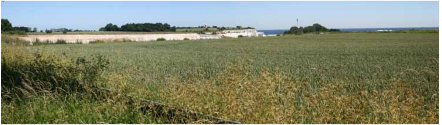
Stevns Kridtbrud ses som et hul i morænefladen. De tekniske anlæg er placeret nede og påvirker dermed ikke landskabet i særlig grad.
