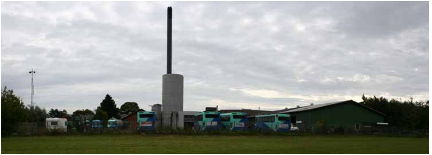
Skorsten, lagerbygning, mast og trådhegn giver en massiv teknisk påvirkning.
