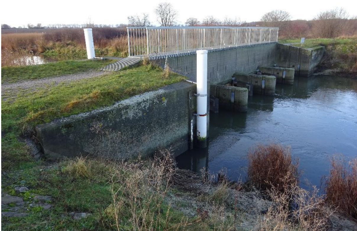
Figur 6: Forsiden af slusen, set fra den sydøstlige side.
