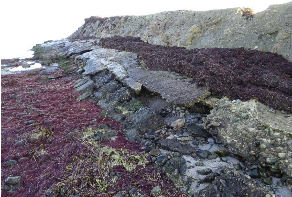
Figur 38: Betonsikring af sand ved foden af h fden.
