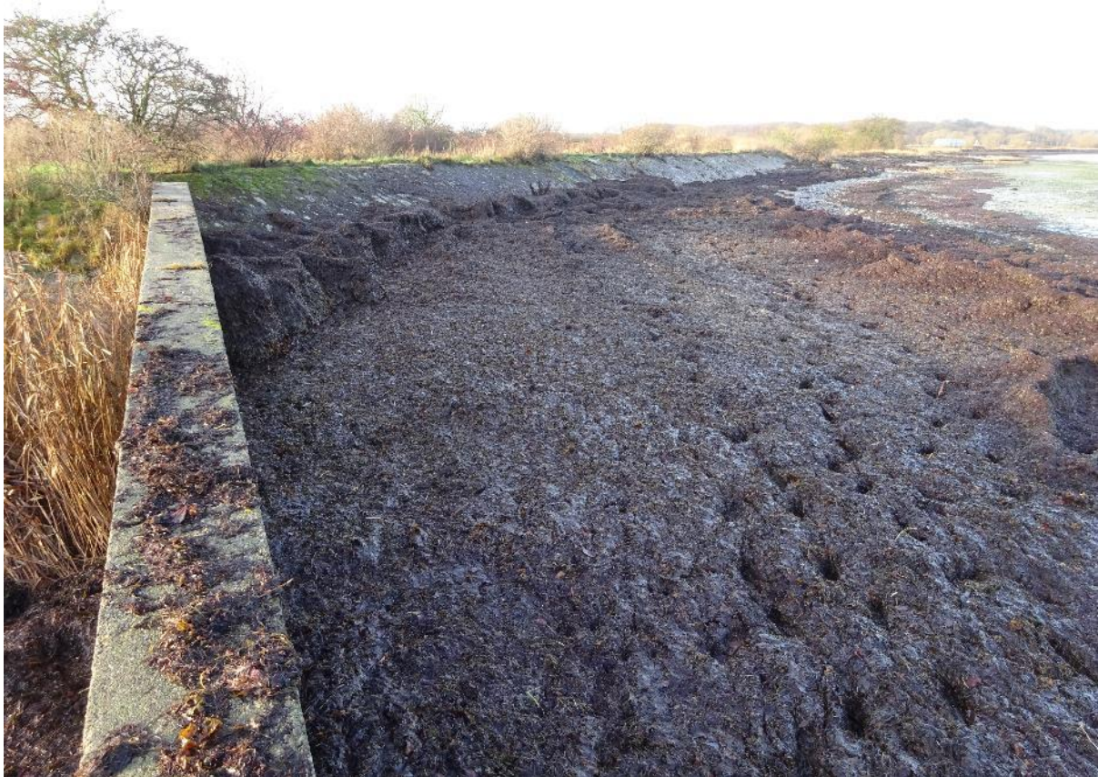
Figur 22: Betonmur i den østlige ende af delstrækningen, set fra øst.
