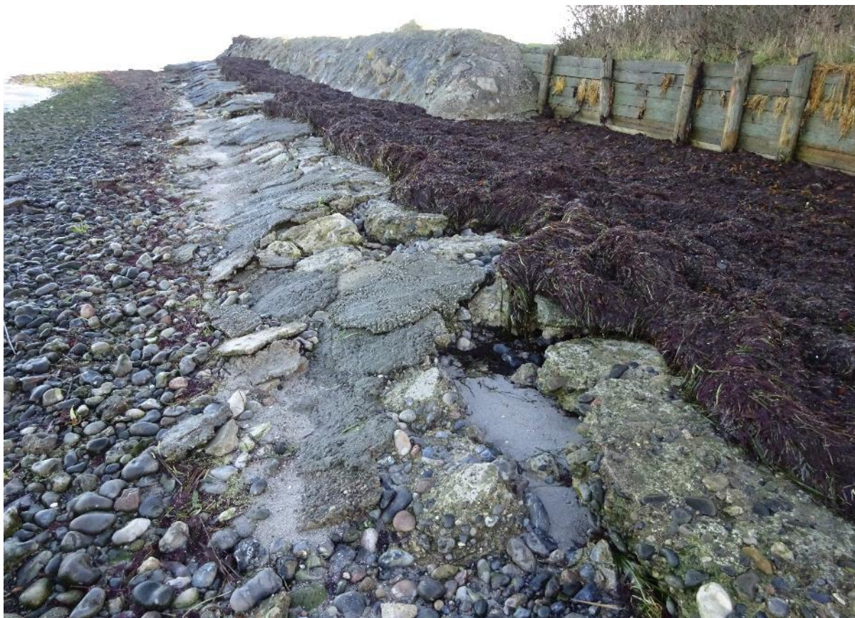
Figur 36: Overgang mellem træflagevæg og sten.
