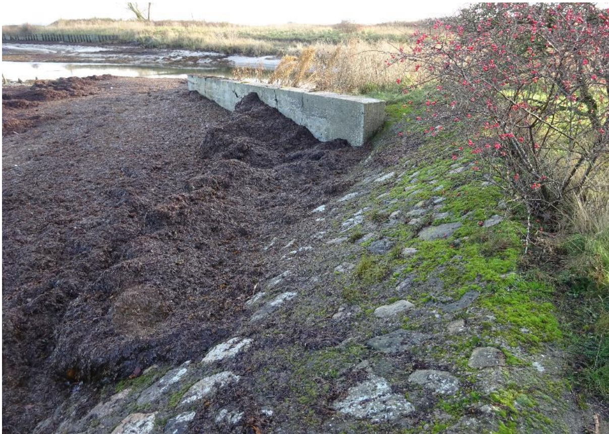
Figur 23: Den østlige ende af delstrækningen.
