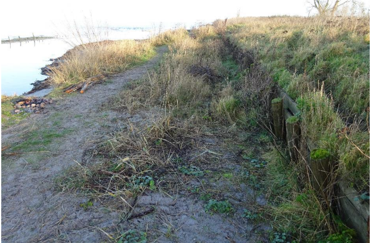
Figur 30: Den inderste del af ledeværket, med træflagevæg og åbrink af sand.
