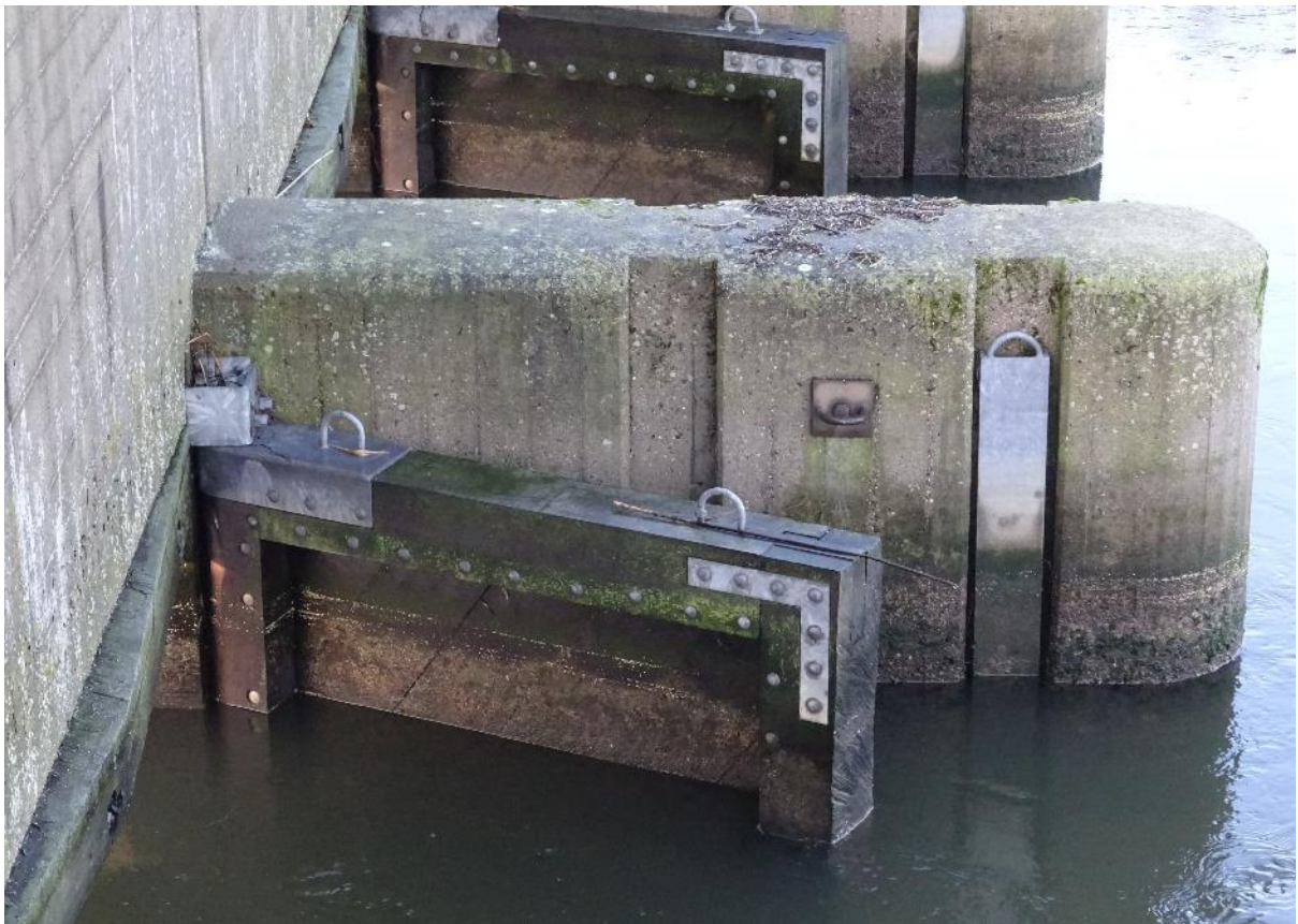
Figur 10: Eksempel på beton i god stand på strømpillerne.
