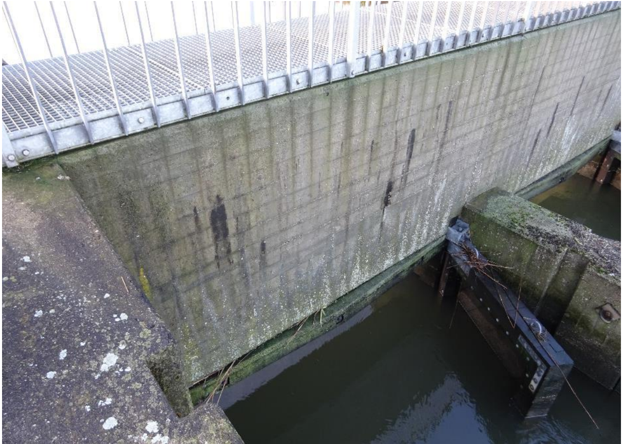
Figur 9: Eksempel på beton i god stand på overbygningen af slusen.
