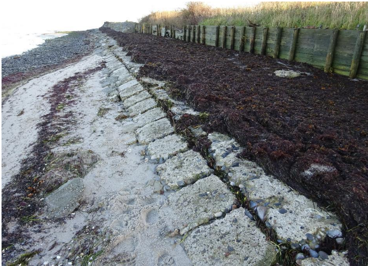
Figur 32: Den midterste del af ledeværket, med træflagevæg og betonsikring af sandstrand.
