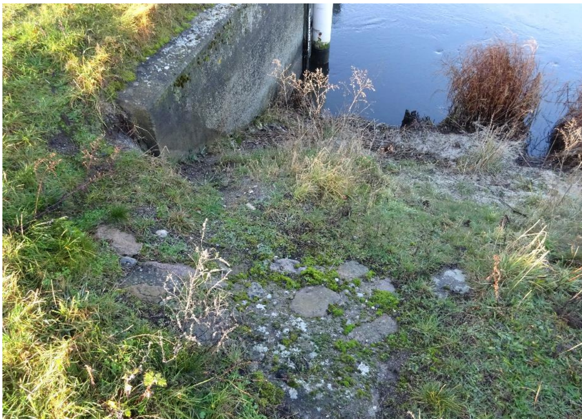
Figur 8: Skråningsbeskyttelse på den sydlige brink, på ydersiden af slusen.
