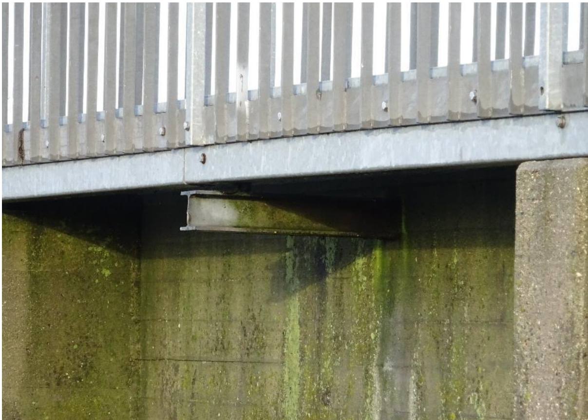
Figur 12: Eksempel på understøtning af gangbro i god stand.
