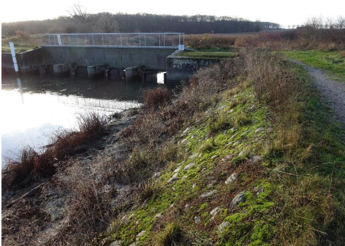
Figur 7: Skråningsbeskyttelse på den nordlige brink, på ydersiden af slusen.
