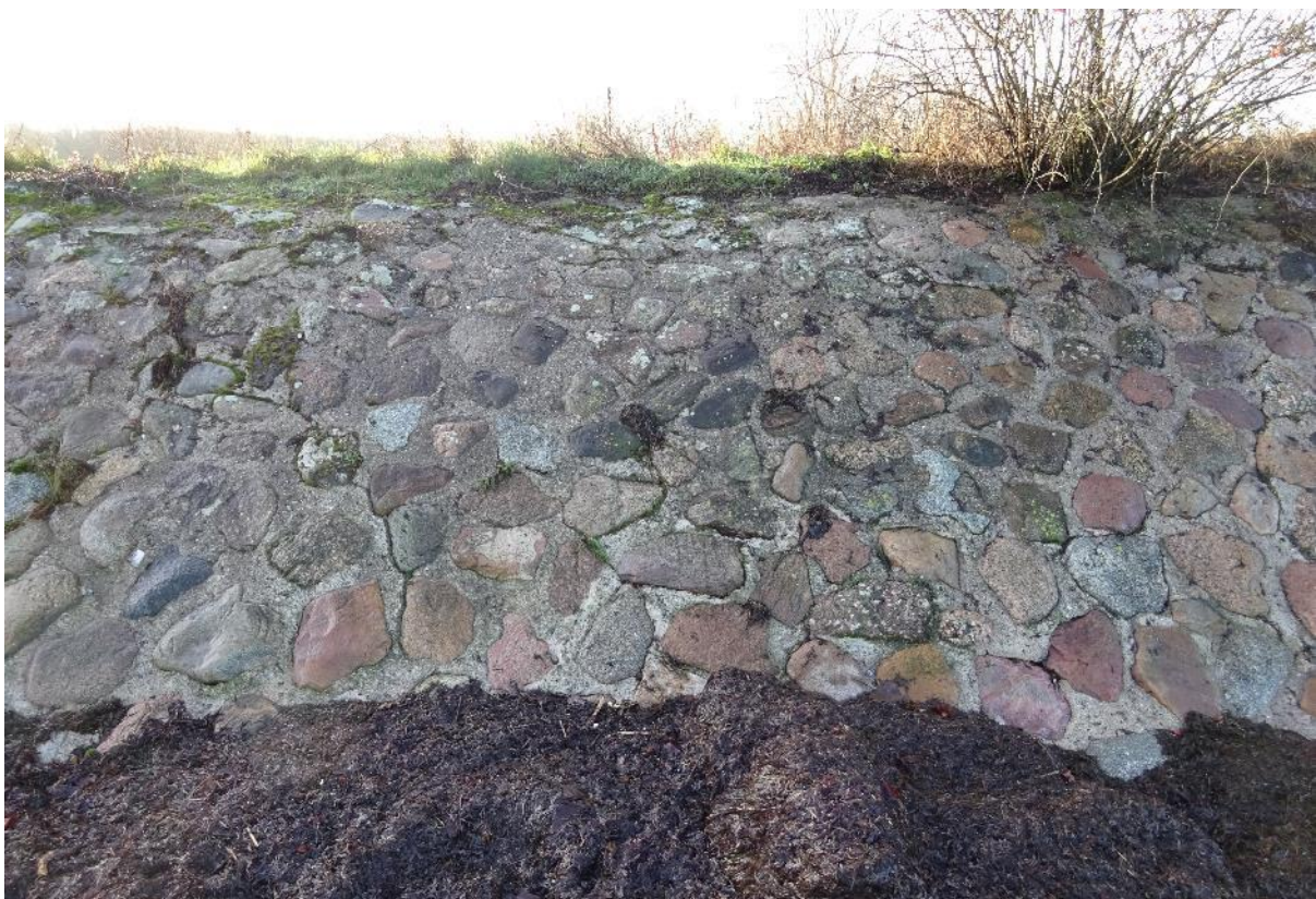
Figur 19: Typisk eksempel på glaciset af sten og beton.
