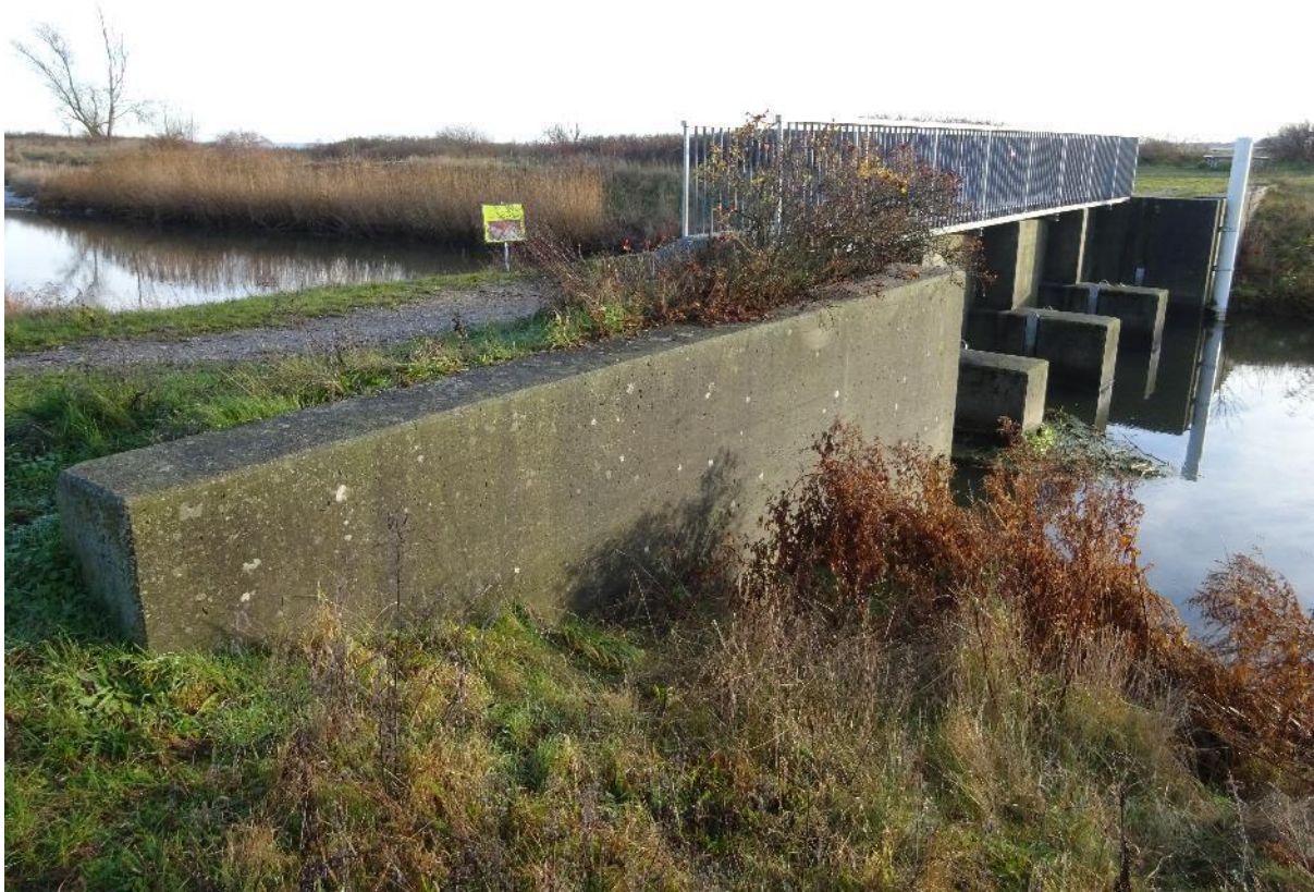
Figur 5: Bagsiden af slusen, set fra den nordvestlige side.
