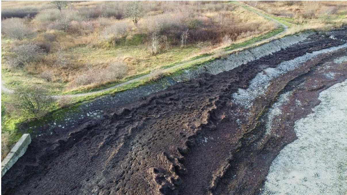
Figur 26: Skråningsbeskyttelsen af den lokale digestrækning set fra drone, fra østlig retning.
