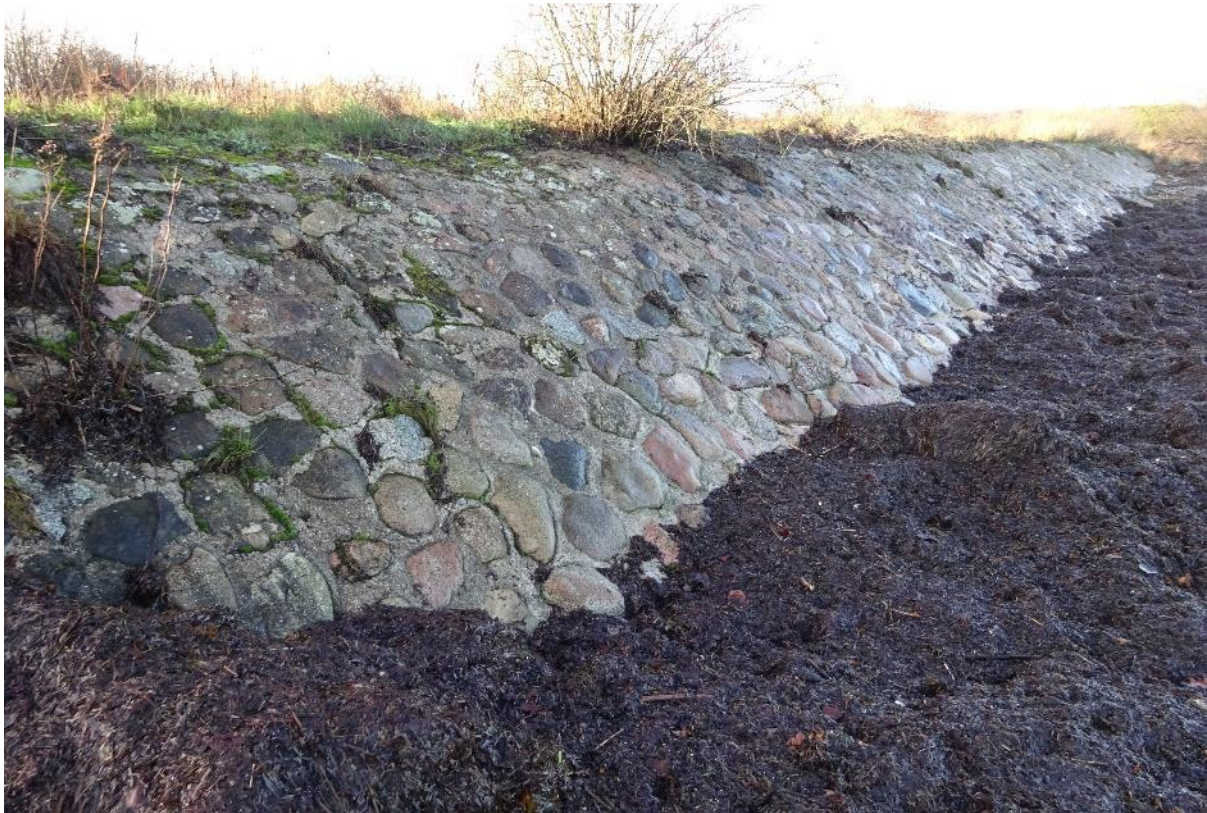
Figur 18: Skråningsbeskyttelse set fra øst mod vest.
