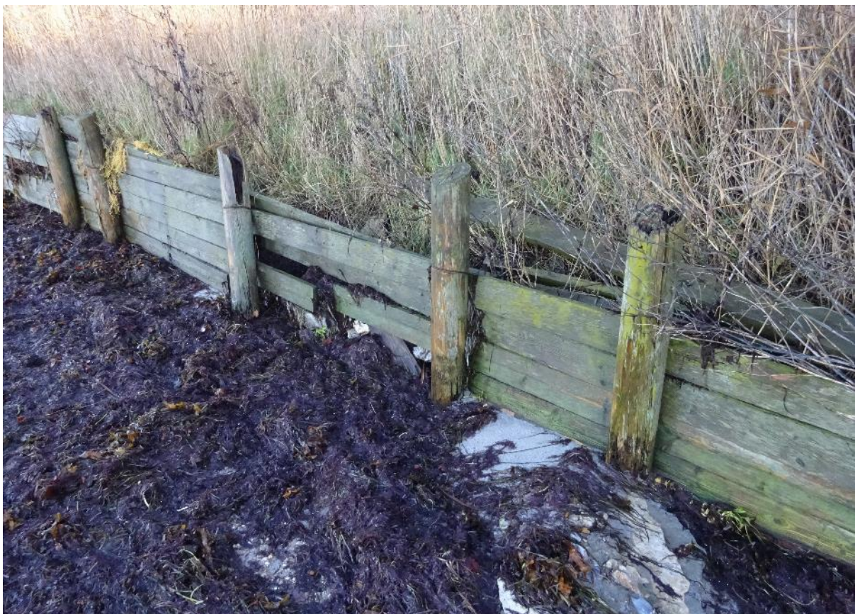
Figur 35: Eksempel på tilstand af træflagevæg.
