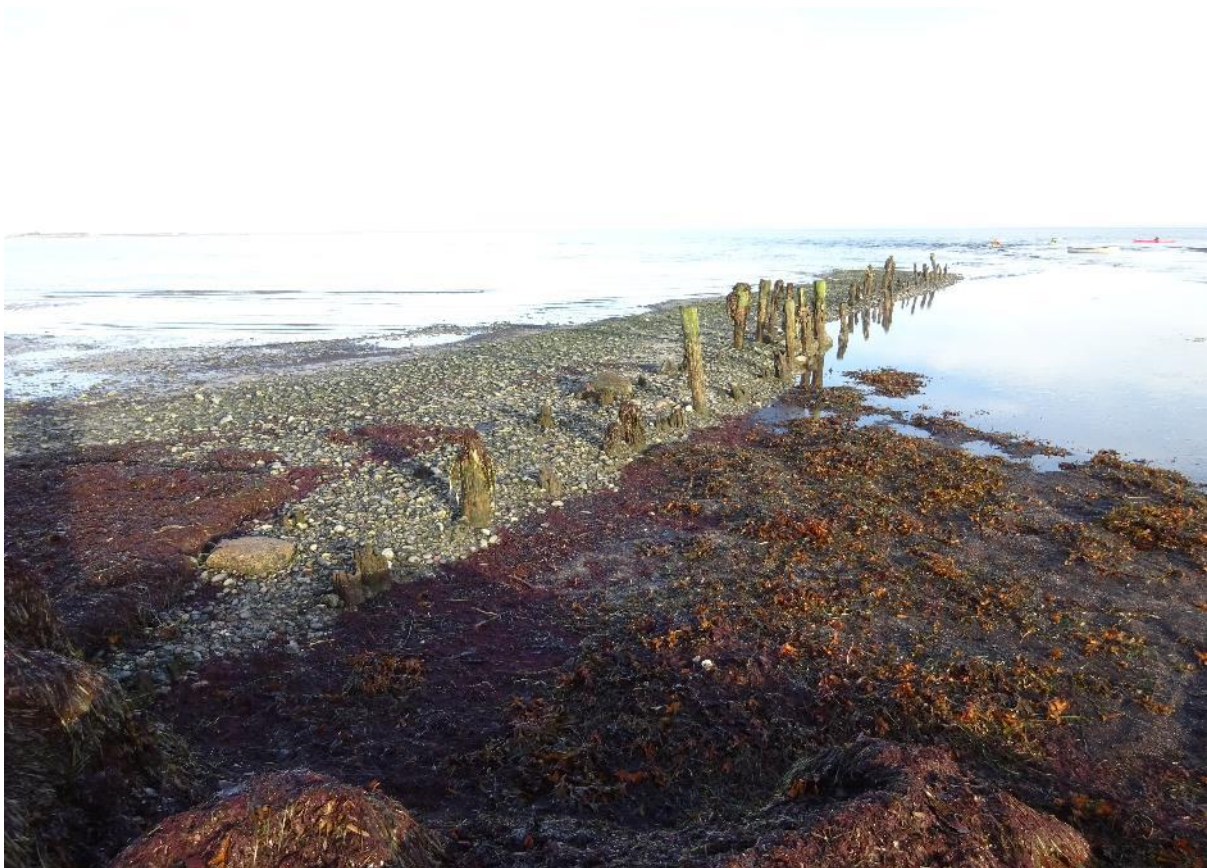
Figur 40: Gammelt ledeværk på den vestlige side af åens udløb.
