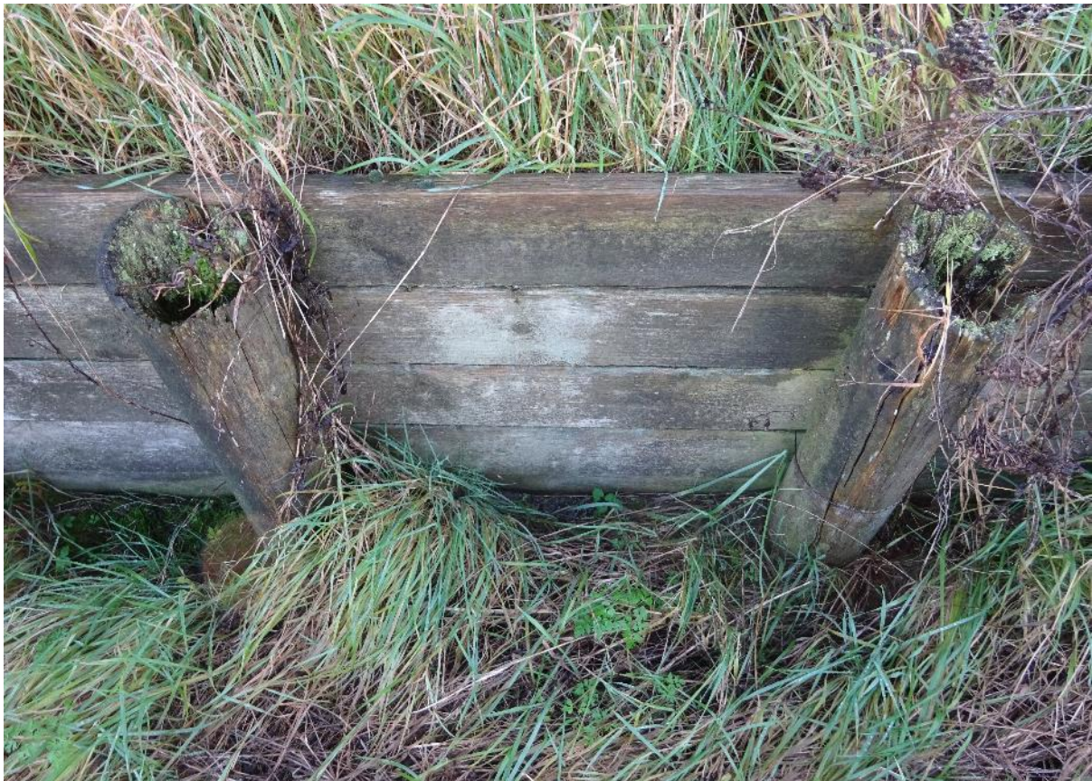
Figur 31: Eksempel på tilstand af træflagevæg.
