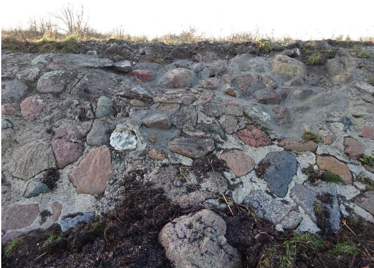
Figur 20: Reparation af glaciset ca. 50 meter fra betonmuren mod øst.
