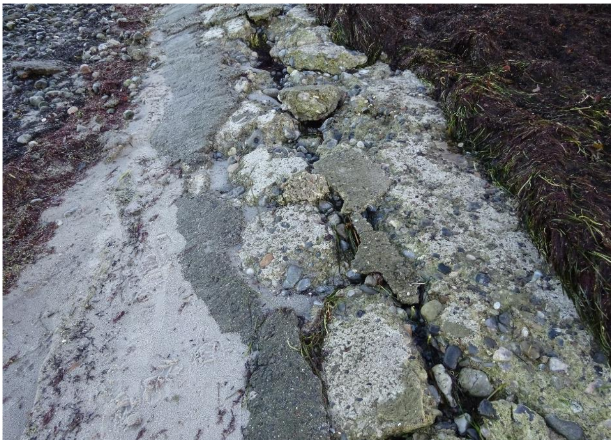
Figur 33: Eksempel på tilstand af betonsikring af sandstrand.
