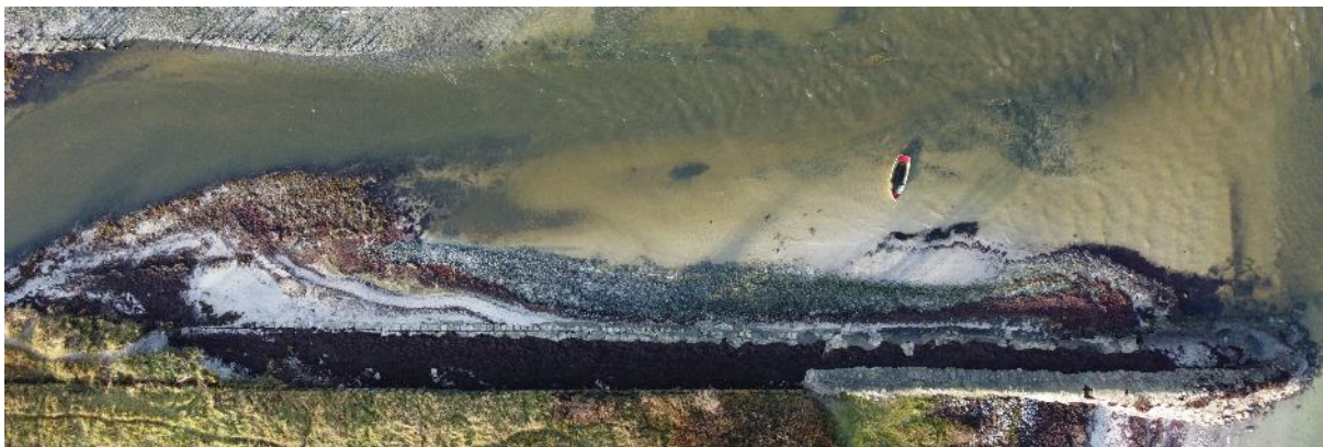
Figur 28: Ledeværket og den yderste hofde set fra oven.
