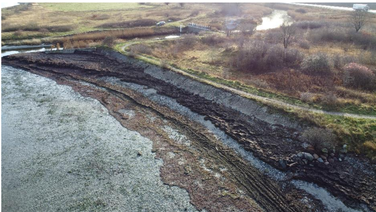
Figur 27: Skråningsbeskyttelsen af den lokale digestrækning set fra drone, fra vestlig retning.
